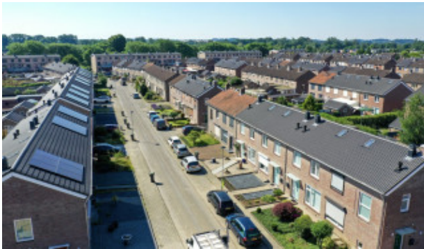
renovatie 154 woningen in Nieuwdorp
