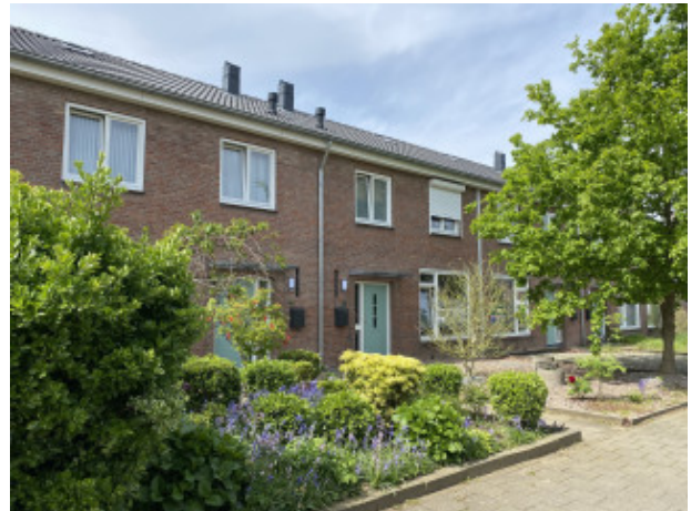
renovatie 154 woningen in Nieuwdorp
